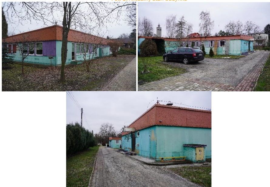
Fot. 5. Aktualny stan budynku
