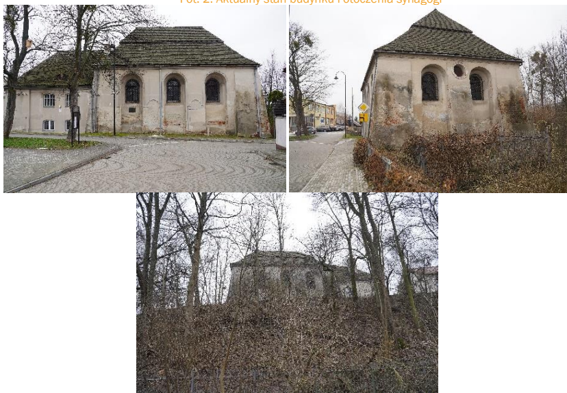
Fot. 2. Aktualny stan budynku i otoczenia synagogi
