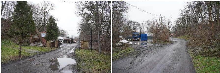
Fot. 6. Aktualny stan obiektu
