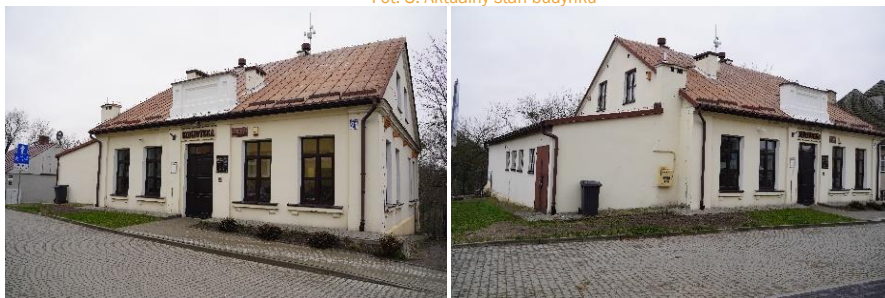
Fot. 3. Aktualny stan budynku
