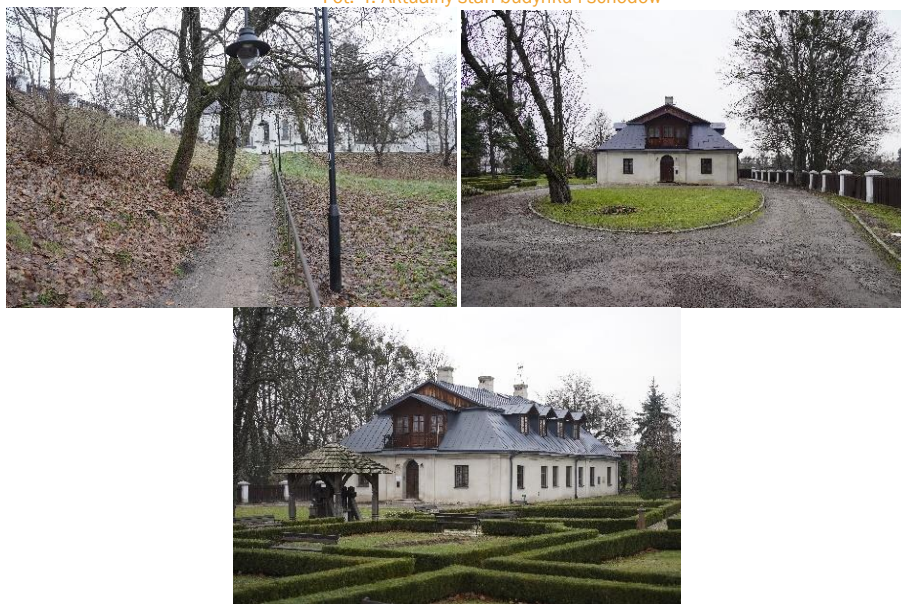
Fot. 4. Aktualny stan budynku i schodów
